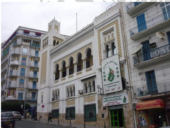
Figura III: Projetado por Henri Petit e inaugurado em 1906, o edifício serviu de sede para o jornal La Dépêche Algérienne . Hoje abriga o Rassemblement Démocratique National . Disponível em: < http://mutual-heritage.crevilles-dev.org/ >. Acesso em 06 nov. 2014.
